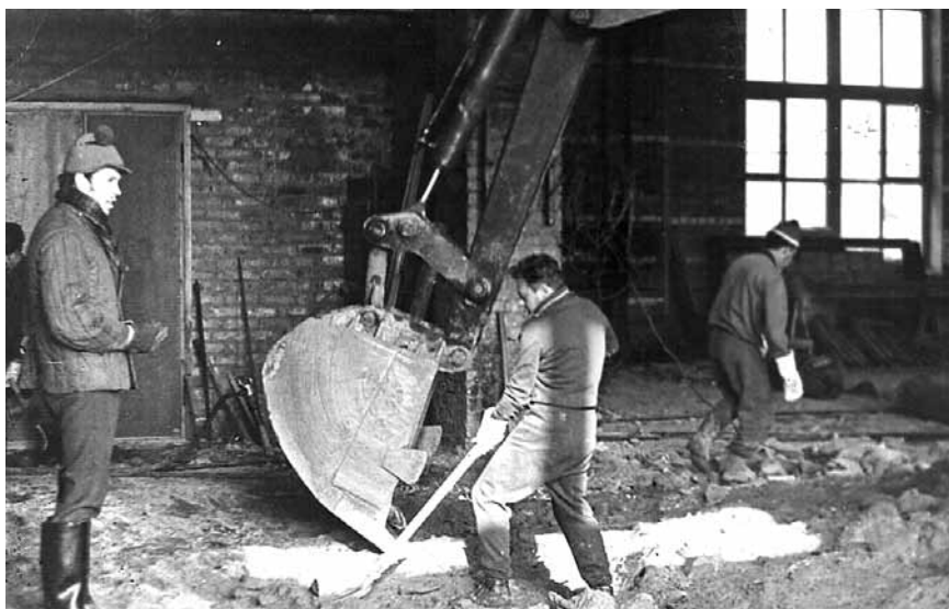
Немчинов Г.Н. на строительстве техчасти
